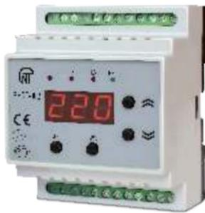
**РНПП-316-500** предназначено для измерения действующего значения линейного напряжения трехфазной сети и выполняет следующие функции:
